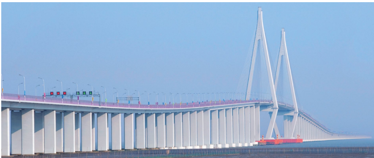
Die 7.000 im Meeresboden verankerten Brückenpfeiler der Hangzhou Bay Bridge in China wurden mit Protectosil® CIT gegen das Eindringen von Meerwasser geschützt
