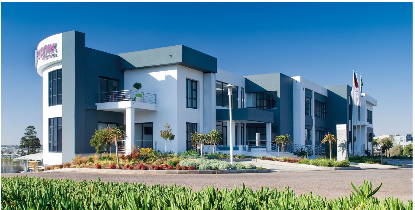
Das Evonik Gebäude in Johannesburg, Südafrika, ist gegen Wind und Wetter langfristig mit Protectosil® geschützt
