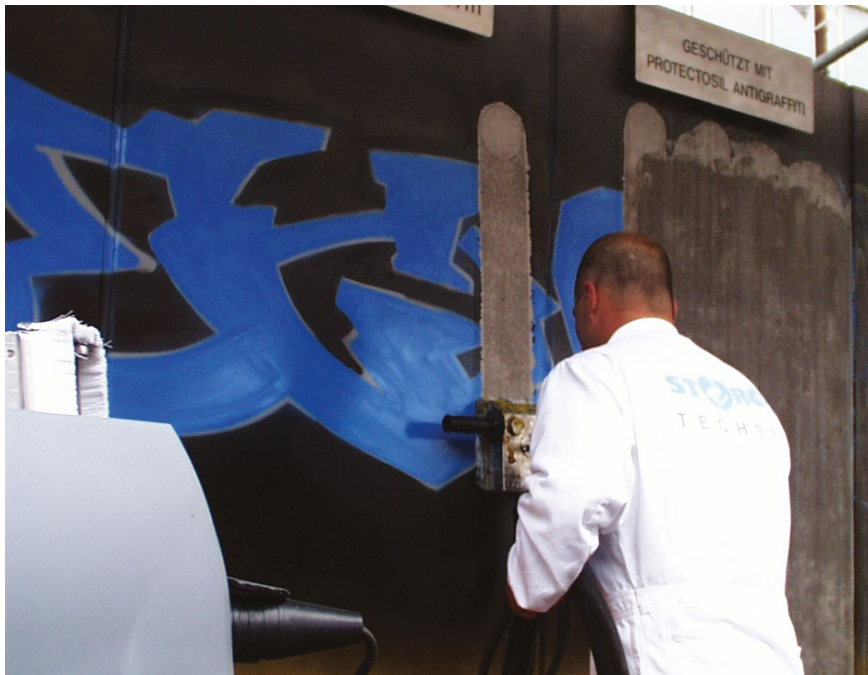
Reinigung einer mit Graffiti verunreinigten Wand
