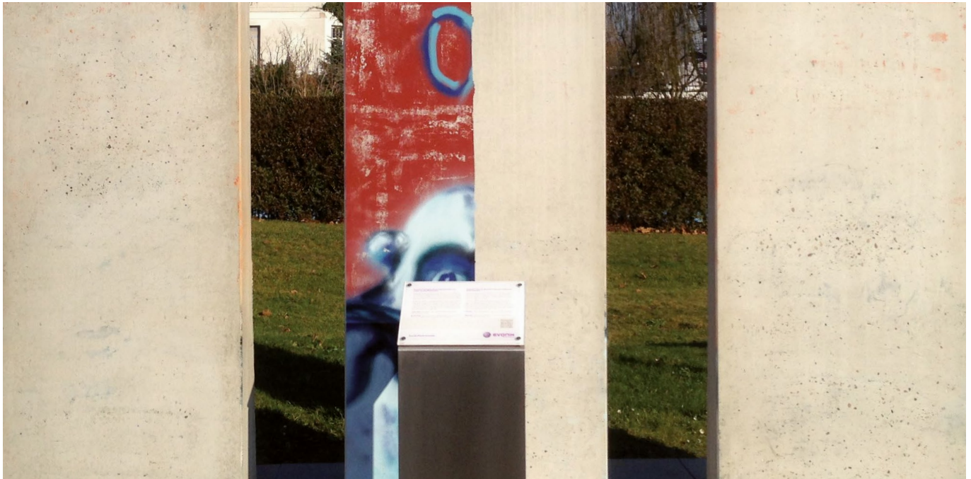
Betonwand nach Entfernung von Graffiti ohne Rückstände
