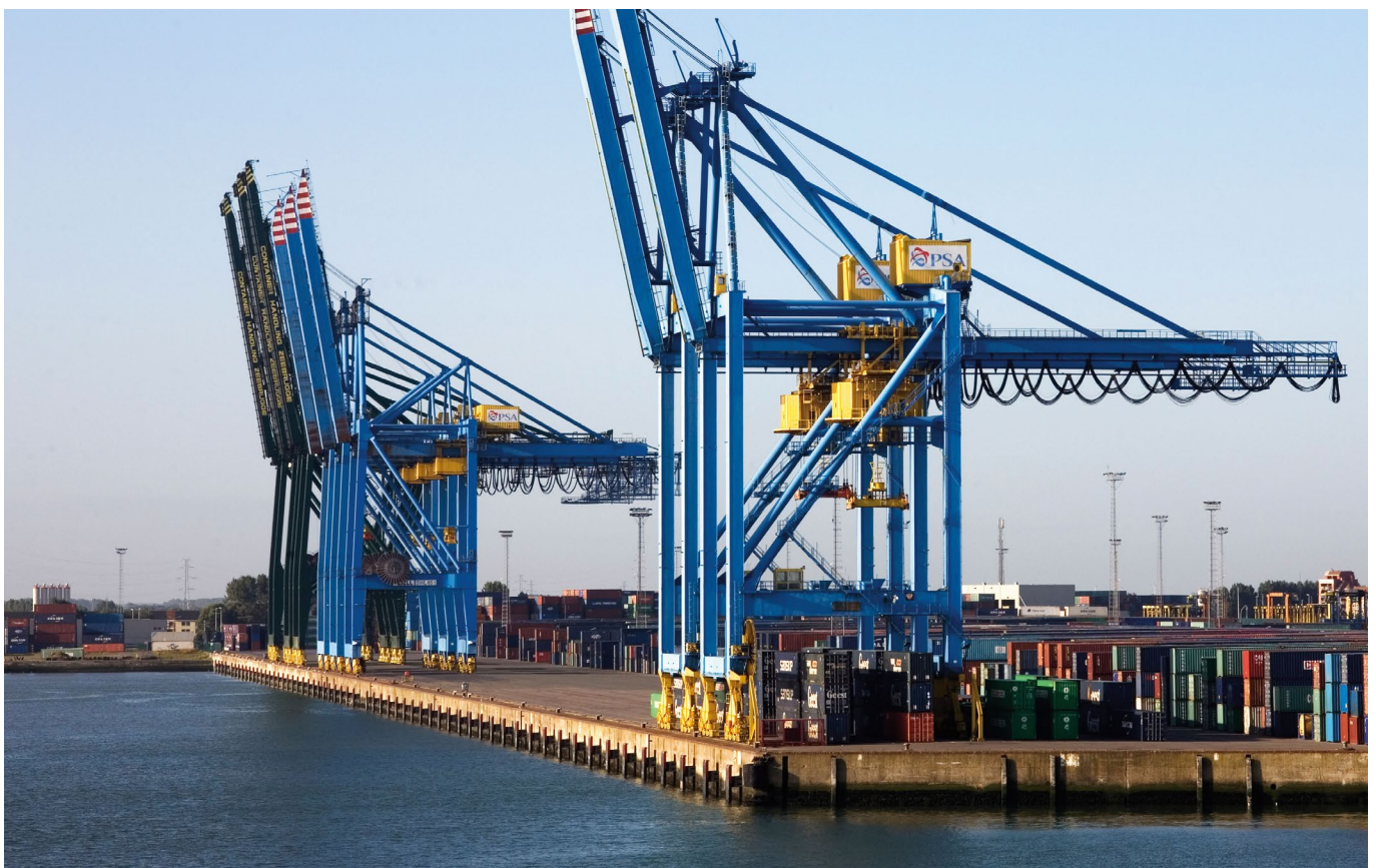
Die Kaimauer des Containerhafens Zeebrugge in Belgien ist mit Protectosil® optimal gegen Korrosion geschützt
