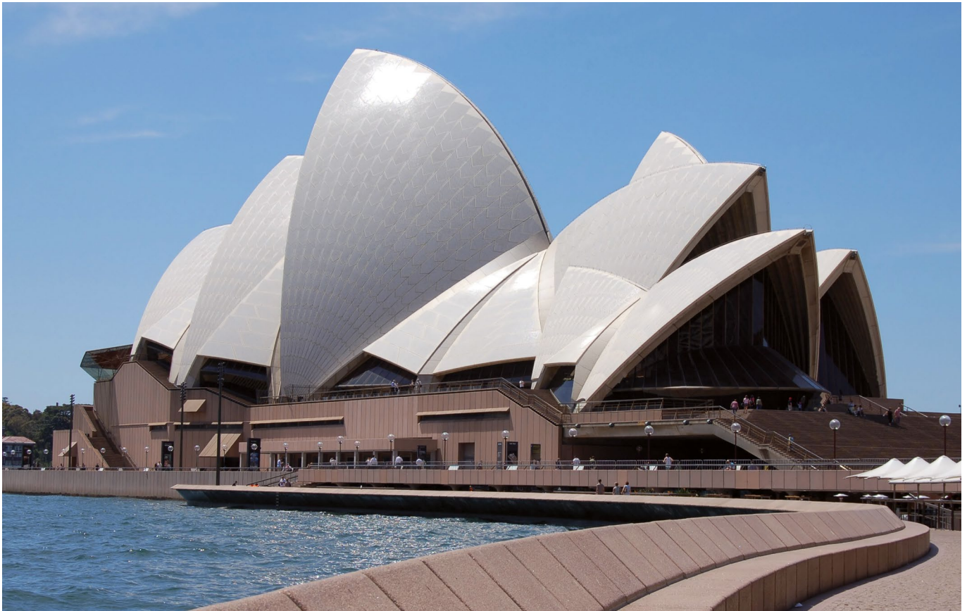
Protectosil® schützt das Opernhaus in Sydney vor Umwelteinflüssen
