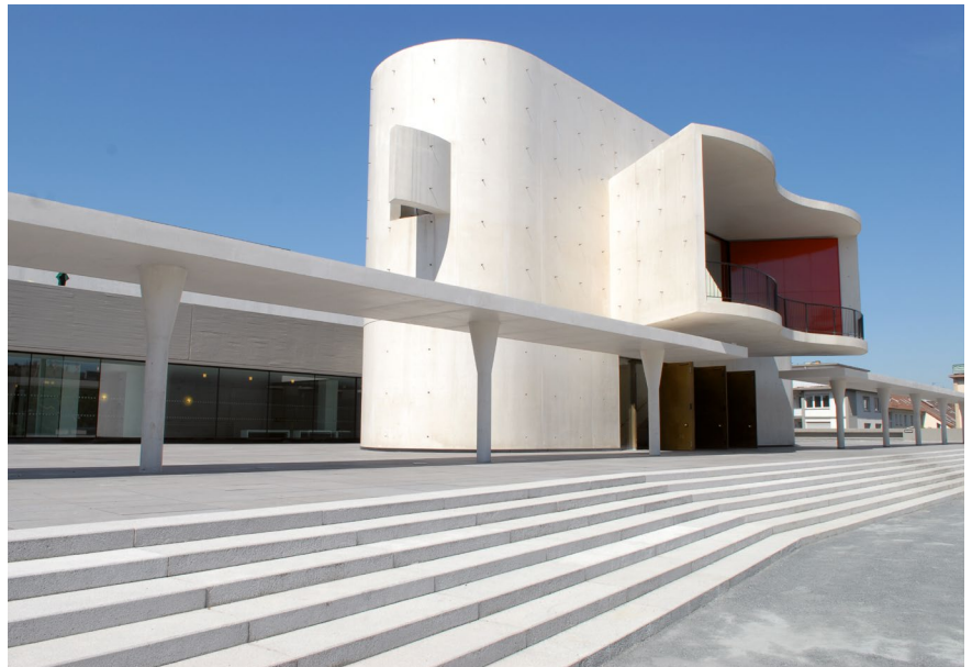
Protectosil ANTIGRAFFITI® schützt die helle Marmorfassade des Staatstheaters Darmstadt
