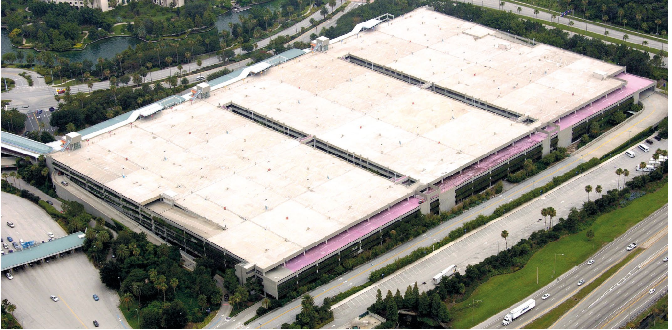
Die Parkflächen der Universal Studios in Orlando, Florida, wurden mit Protectosil® CIT gegen Korrosion geschützt
