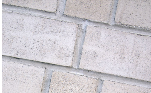
Mit Protectosil® SC CONCENTRATE behandelt (nicht gereinigt)
