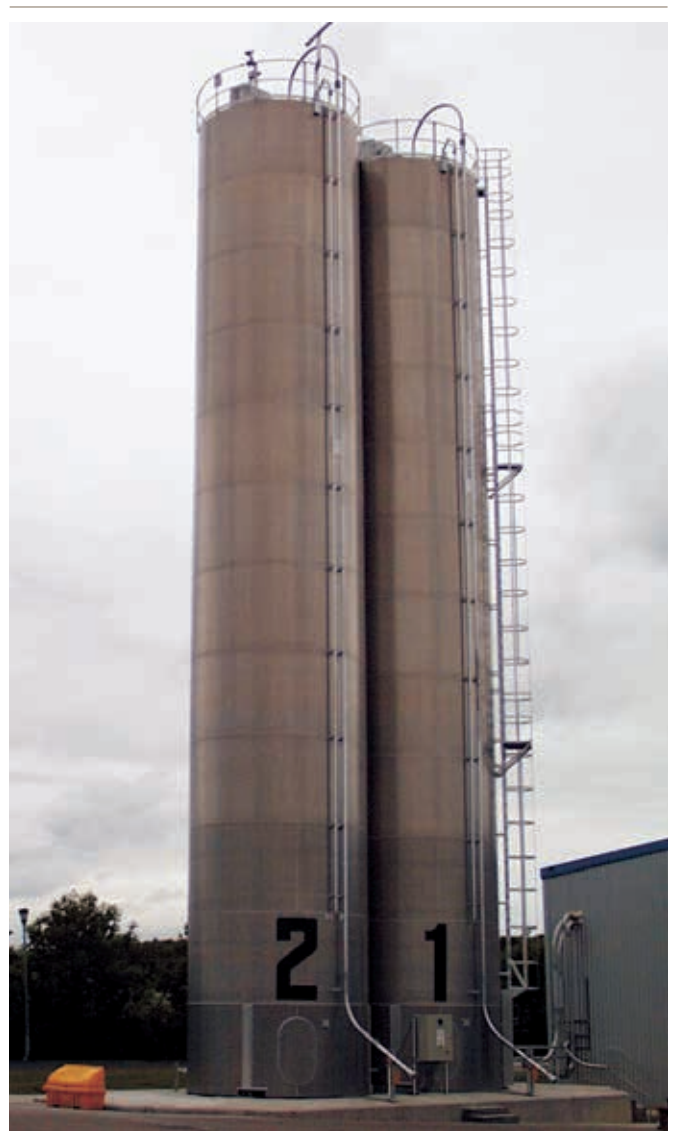
Abbildung 18 Lagersilo für synthetische Kieselsäuren
