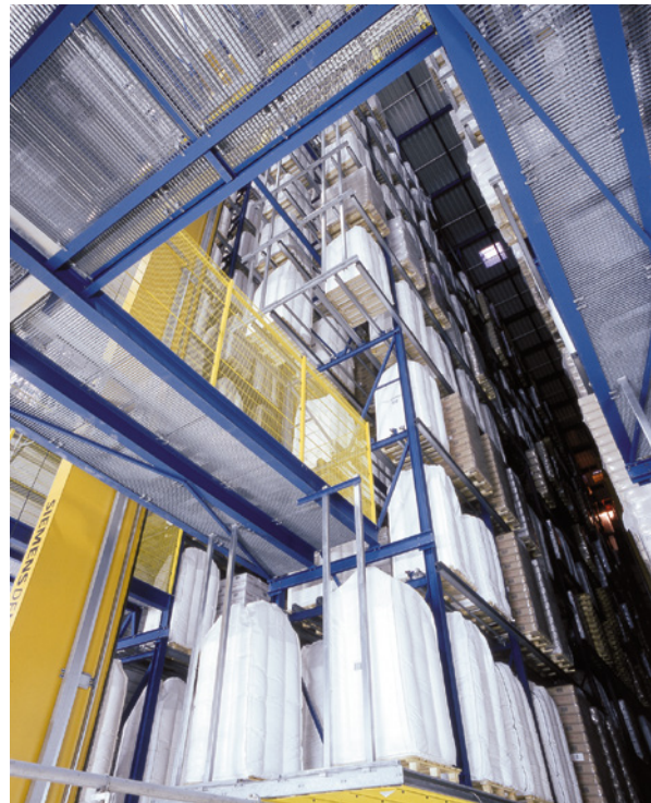
Abbildung 9 Stückgutlager (Hochregal) für Sackware oder Semi-Bulk-Gebinde
