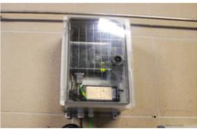
Gateway Siemens IoT mit WiFi sendet Daten zur Siemens IoT Cloud
