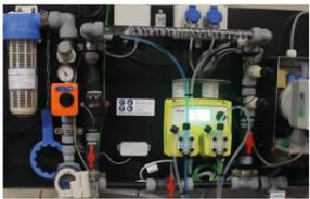
Dosiereinheit mit Wasserzähler, Sensoren und Pumpe injiziert Oxidationsmittel und Säure in die Tränkleitung
